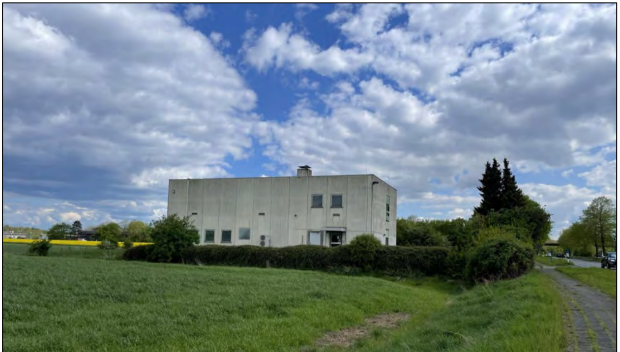
Abbildung 29: Blick von Norden auf das Bestandsgebäude der Telekom (IBU, 2024)
