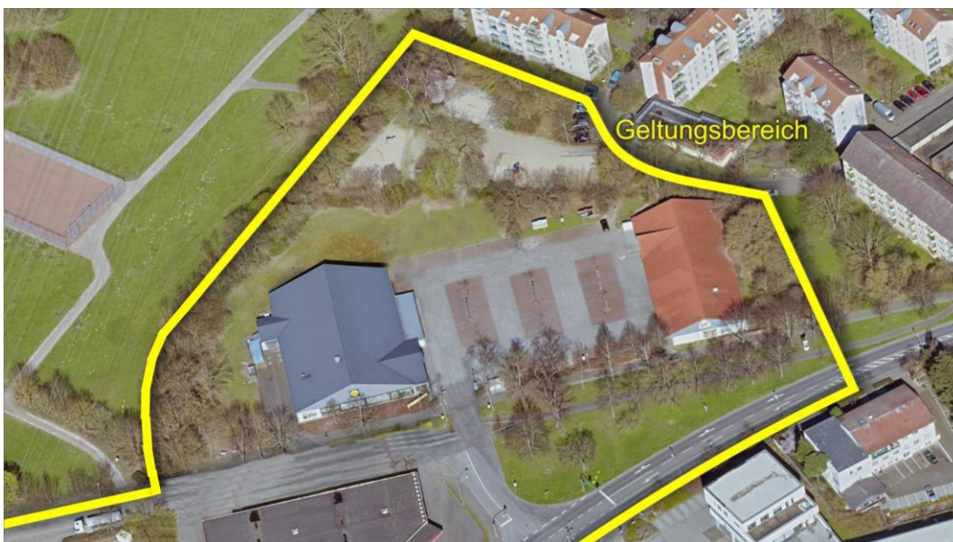
Abb. 6 Nördlicher Teil des Plangebietes mit Lebensmittelmarkt-Parkplatz und Getränkemarkt (Quelle Luftbild: Universitätsstadt Gießen, 2020, Getränkemarkt mittlerweile rückgebaut)
