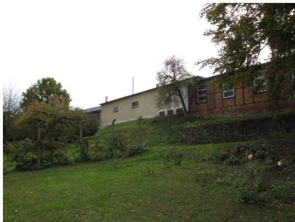
Ansicht Poppe aus Richtung Norden von der Elsa-Brandström-Straße
