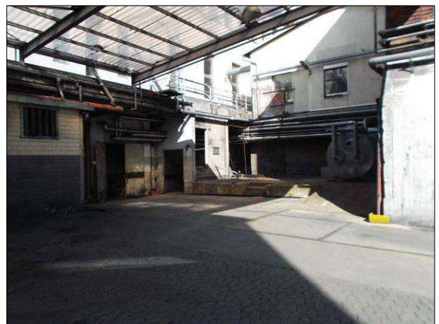
Abb. 18: Innenhof östlich der ehemaligen Werkstatt mit vielen offenen Hohlräumen und Gebäudeeingängen.
