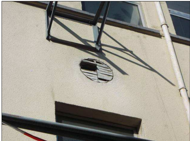
Abb. 13: Offener Lüftungsschacht an alter Werkshalle des Poppe-Geländes
