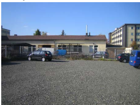
Foto 5: Geschotterter Parkplatz im Nordosten
