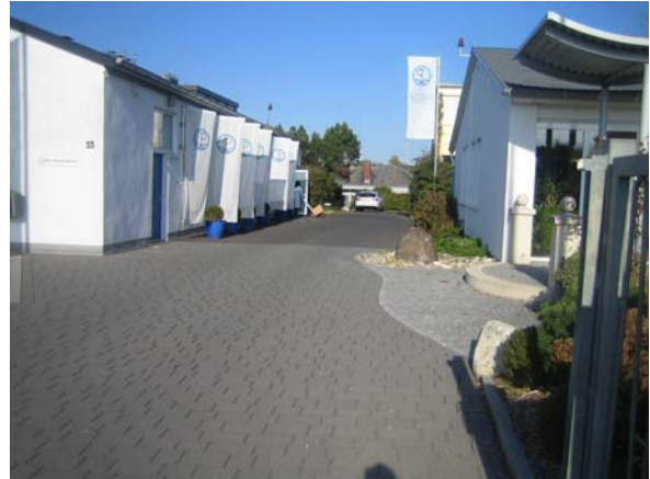
Foto 2: Gebäude und befestigte Hofflächen auf dem Betriebsgelände
