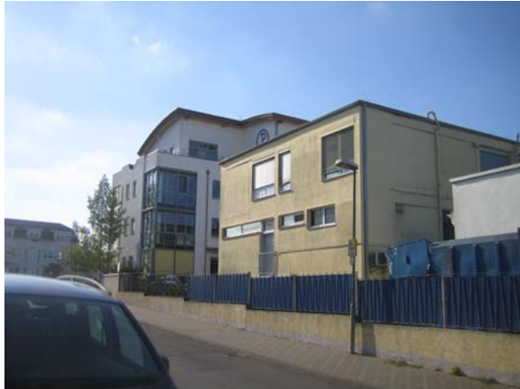
Foto 1: Gebäude der Fa. Pascoe, Blick vom Klingelbachweg
