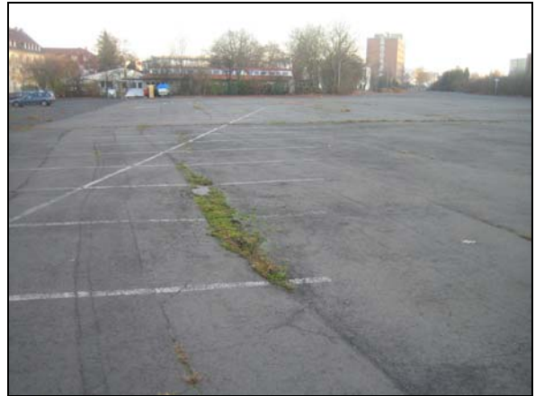
Foto 4: Bewachsene Asphalttrasse im Bereich des Werksparkplatzes
