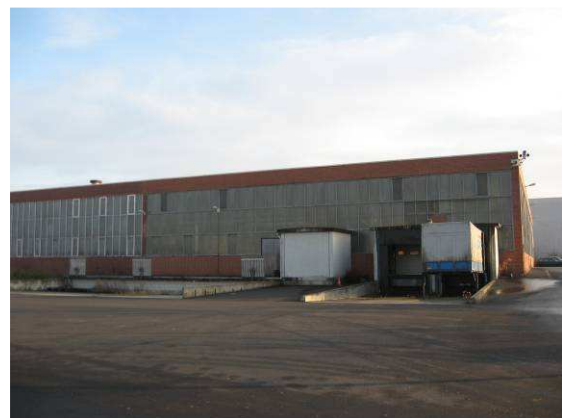
Logistik-Halle im Nordteil
