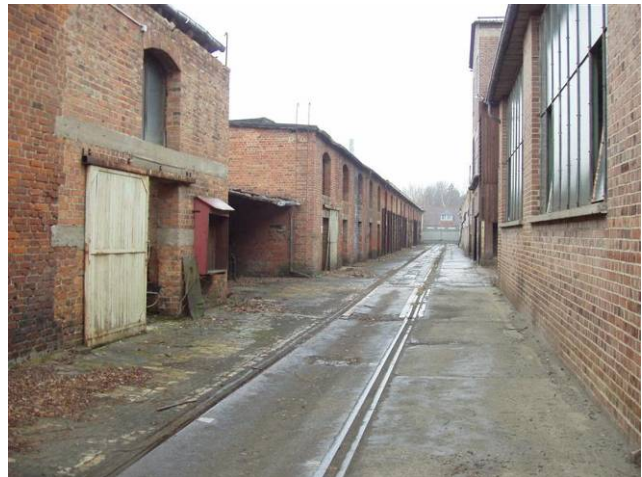
Abb. 12: Lagerhallen im südlichen Teil
