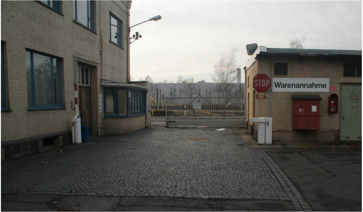
Abbildung 4: Eingangstor im Westen des Bänninger-Geländes (ca. 4 m breit)
