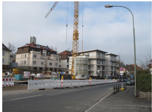
1. BA Appartementanlage Fa. Winter Projektbau
